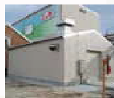
新設した危険物の保管倉庫
