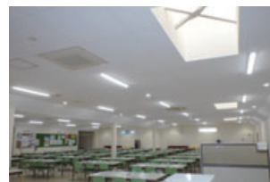
食堂のLED照明
