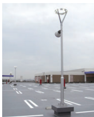
駐車場の照明をLED化
