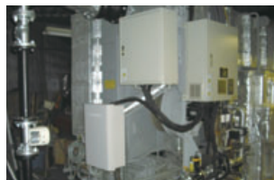
熱源機の更新
