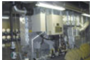
熱源機の更新
