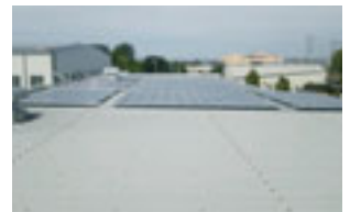
屋上自然力応用遮熱シートの導入
