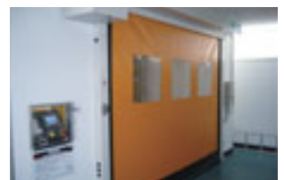
昇降機出入口へのシャッター取り付けによる室内空調の効率化
