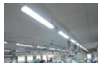
LED照明の導入
