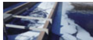
排水路・貯水槽の改修
