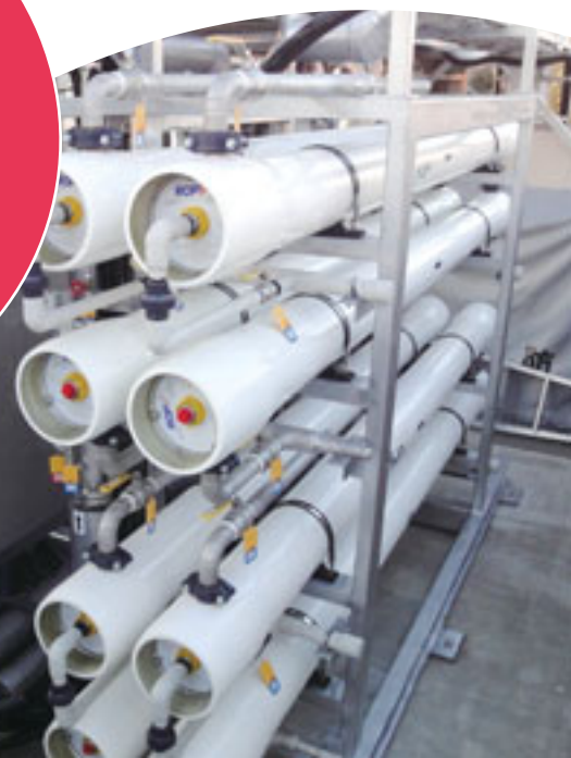
排水リサイクル設備(左:UF膜、右:RO膜)
