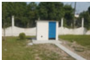
生活排水用流量計室
