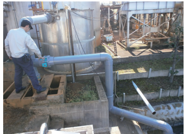
岐阜工場 排水異常時の対応訓練
